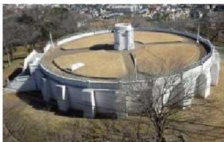
千葉分場1号配水池 (千葉市)
