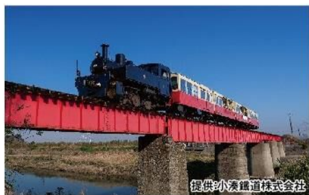
小湊鉄道第一養老川橋梁 (市原市)
